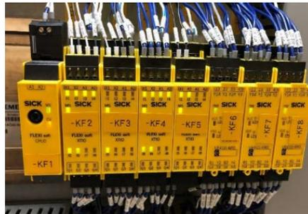
Figura 26. Relevador de seguridad SICK
