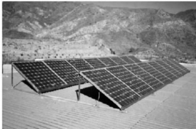
*Figura 54.- Montaje de paneles solares ya con inclinación y separación entre paneles definida sobre techo.*
