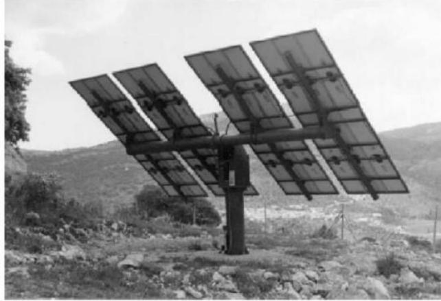
*Figura 53.- Montaje de paneles solares sobre piso con guía de inclinación*
