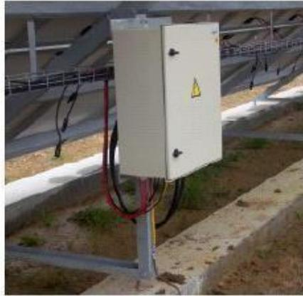
*Figura 58.- Caja de Conexión porta-Fusible*
