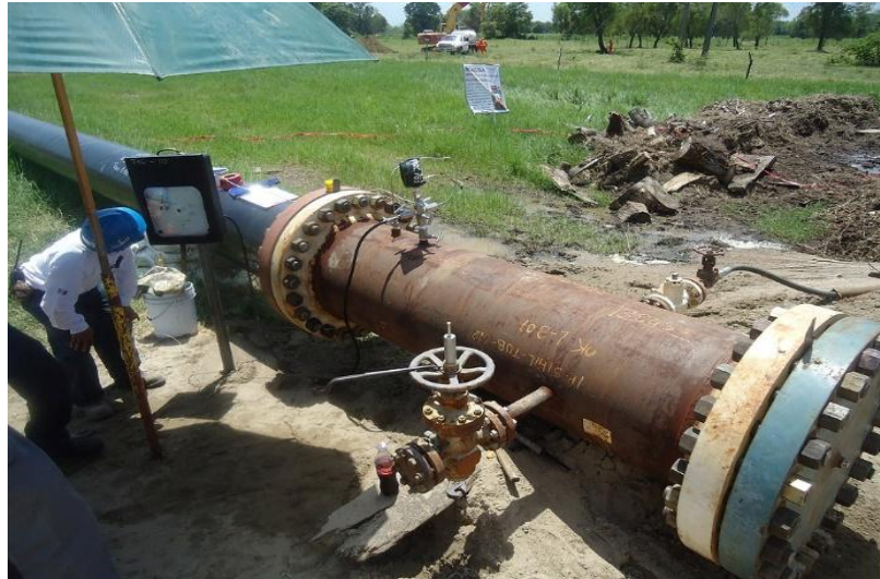
Figura. 2.10 Prueba de presión hidrostática (Pemex)
