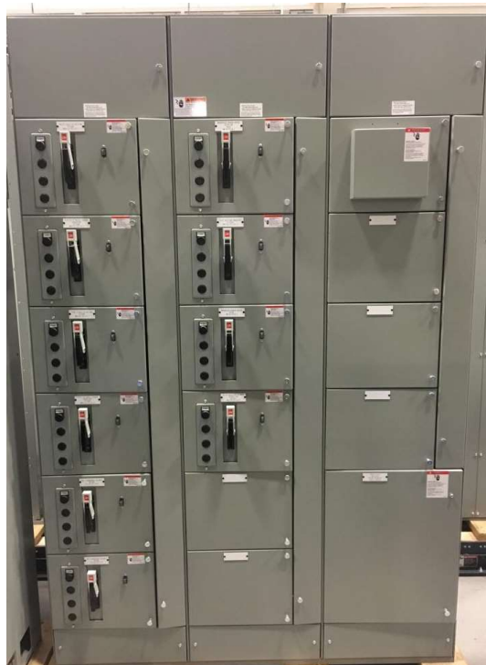
Figura 1. Panel MCC, estructura principal realizada a través del proceso de punzonado.
