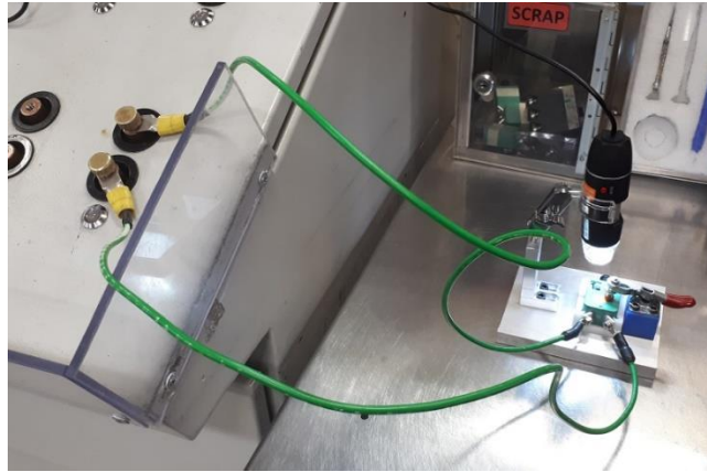
Figura 44. Disyuntor conectado a fuente eléctrica.
