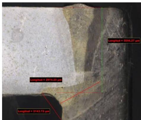
Figura 26. Penetración de soldadura aceptable axial y radial. (Elaboración propia)
