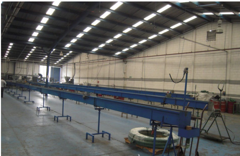
Figura 6 Tinas de enfriamiento para manguera rural
