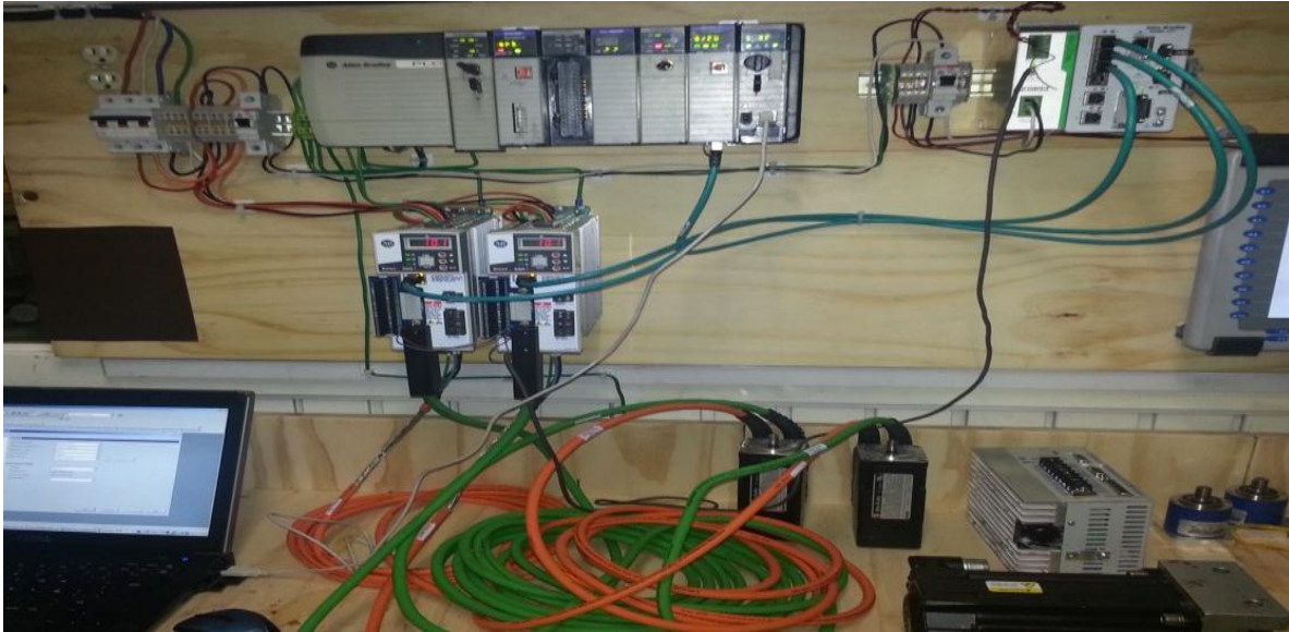
Figura 21. Implementación a nivel laboratorio de algoritmos en PLC
