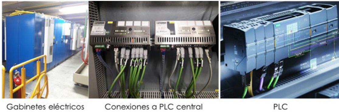
Figura 38. Conexión de gabinetes eléctricos y PLC Elaboración propia
