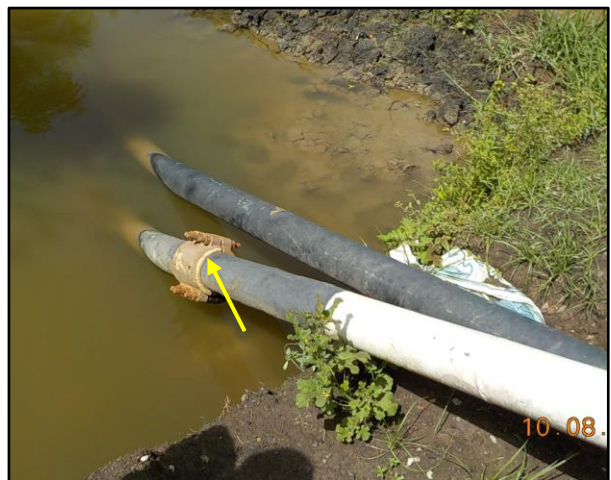
Figura 30. Colocación de grapa-camisa bipartida atornillada marca PLIDCO (Split-Sleeve) en acto vandálico debido a seguetazo.
