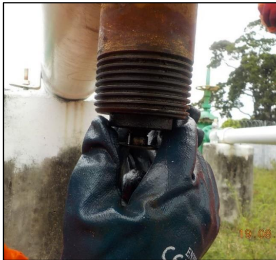
Figura 28. Colocación de tornillo roscado (ver Figura 16) para protección y no dejar visible el área rediseñada.
