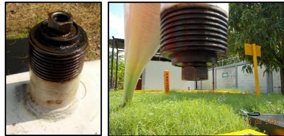
Figura 4. Niple Cosasco® original, se aprecia la tuerca para retiro/colocación de tapón sólido.
