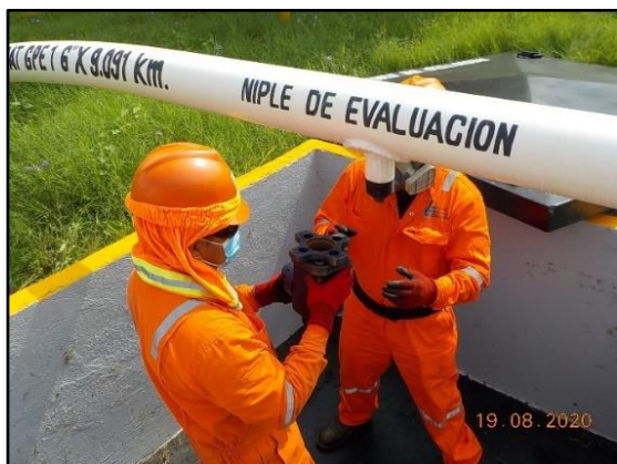
Figura 7. Colocación de Válvula de Bloqueo en Niple Cosasco® previo a la colocación del equipo "retriver".
