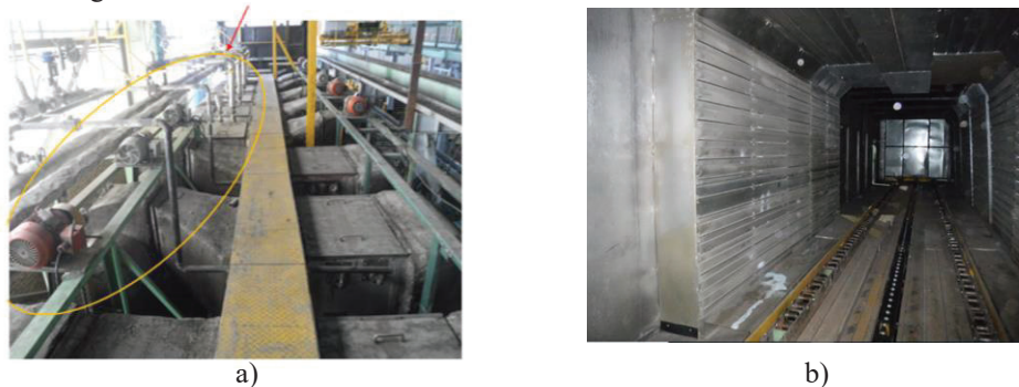
Figura 6. Reconfiguración del horno de convección. a) Modificación en la posición de las turbinas. b) Modificaciones al Interior del horno.
