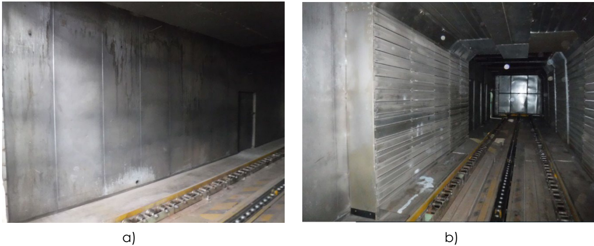
Figura 43. Modificaciones al Interior del horno en las zonas 5 y 6. a) Antes, b) Después. Elaboración propia.
