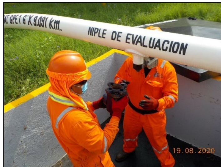
Figura 12. Colocación de Válvula de Bloqueo en Niple Cosasco® previo a la colocación del equipo "retriver". Elaboración propia
