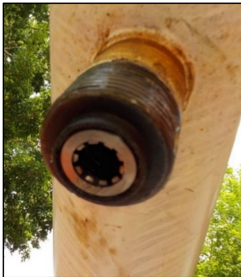
Figura 31. Tapón Sólido Rediseñado en Operación; se puede apreciar que ya no cuenta con la tuerca externa. Elaboración propia
