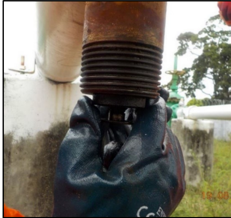
Figura 32. Colocación de tornillo roscado (ver figura 20) para protección y no dejar visible el área rediseñada. Elaboración propia
