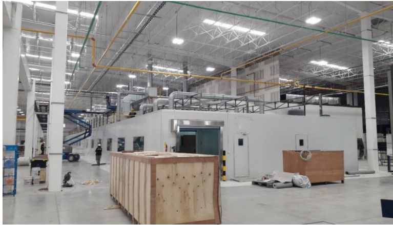
Figura 43. Foto por la parte exterior de la planta de pintura después de terminada. Elaboración propia.
