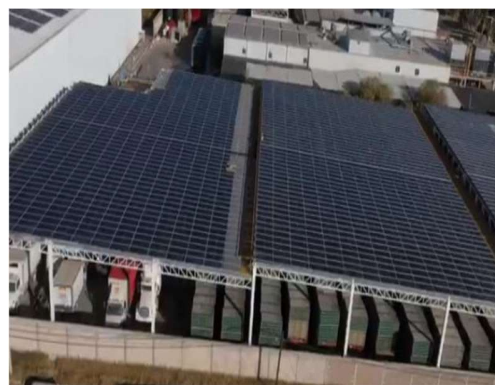
Fig. 17. Estado de los módulos fotovoltaicos después del mantenimiento.
