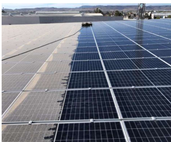
Fig. 11. Limpieza de paneles.
