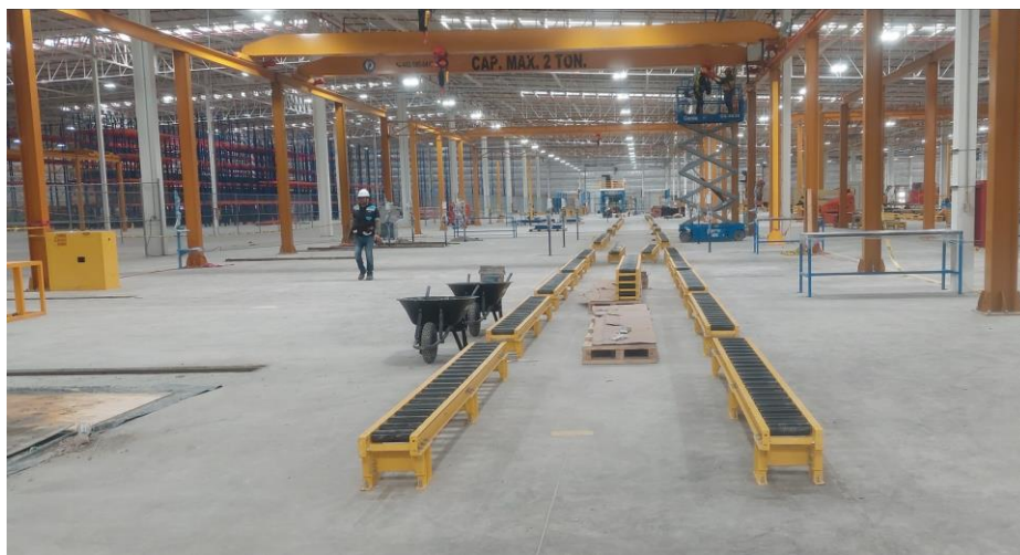
Figura 8.- Línea de ensamble en sus inicios, y antes de implementación de fábrica visual
