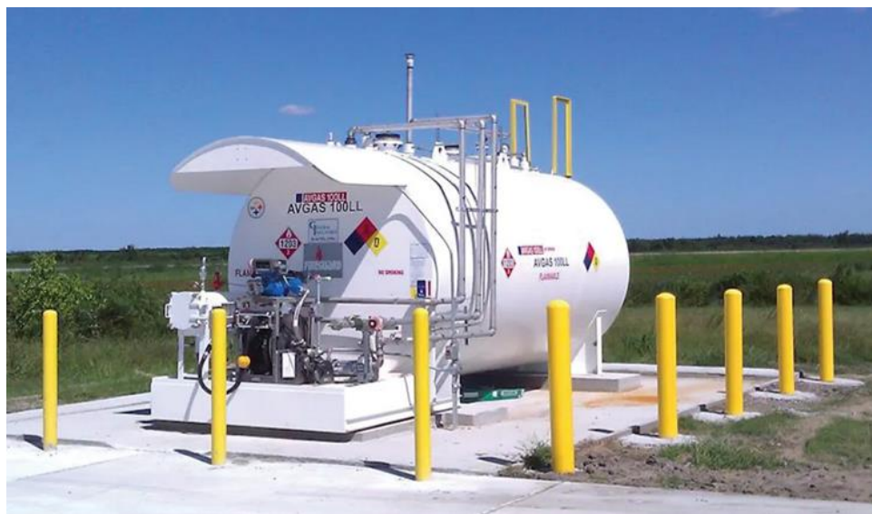
Fig. 4. Tanque autoprotegido UL-2085 (Fuente: Misegades [9]).
