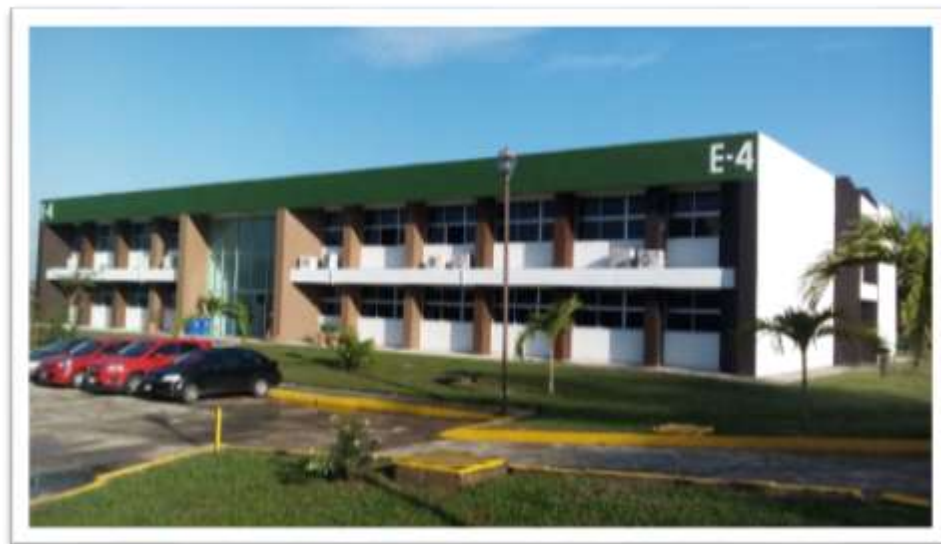
Figura 5. Edificio 4 ITSLV. Fuente: Elaboración propia.
