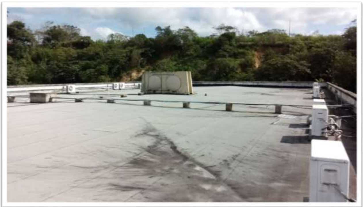
Figura 21. Azotea del edificio 4 del ITSLV
